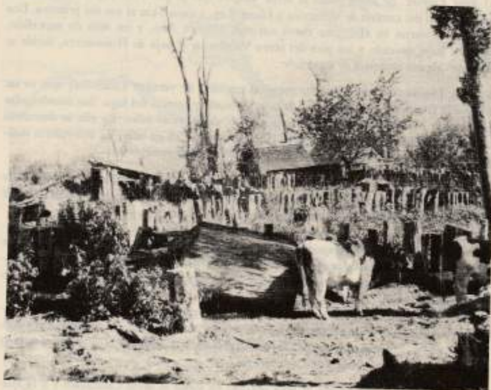
Foto N° 1. Vivienda de una familia de la comunidad de Challupén
