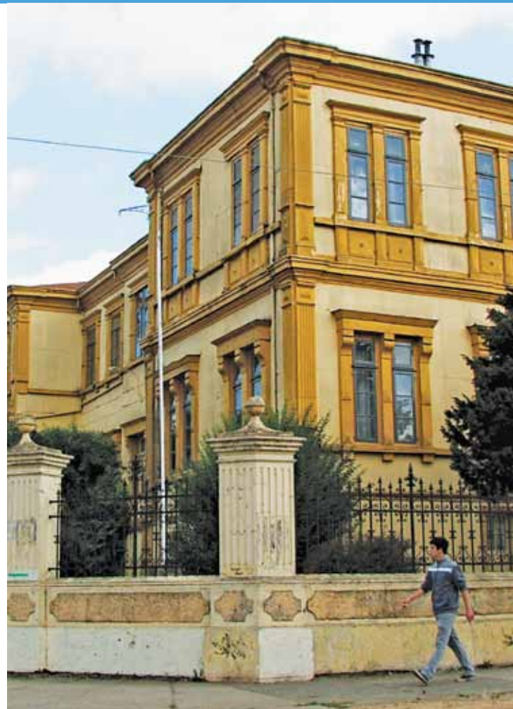
Fig. 40. Escuela de la Cultura. Comuna La Unión. Equipamiento actual, originariamente Casa Duhalde.
