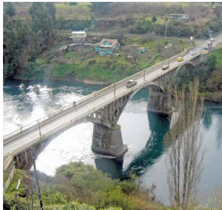
Fig. 41. Puente Río Bueno. Comuna Río Bueno. Infraestructura vial.
