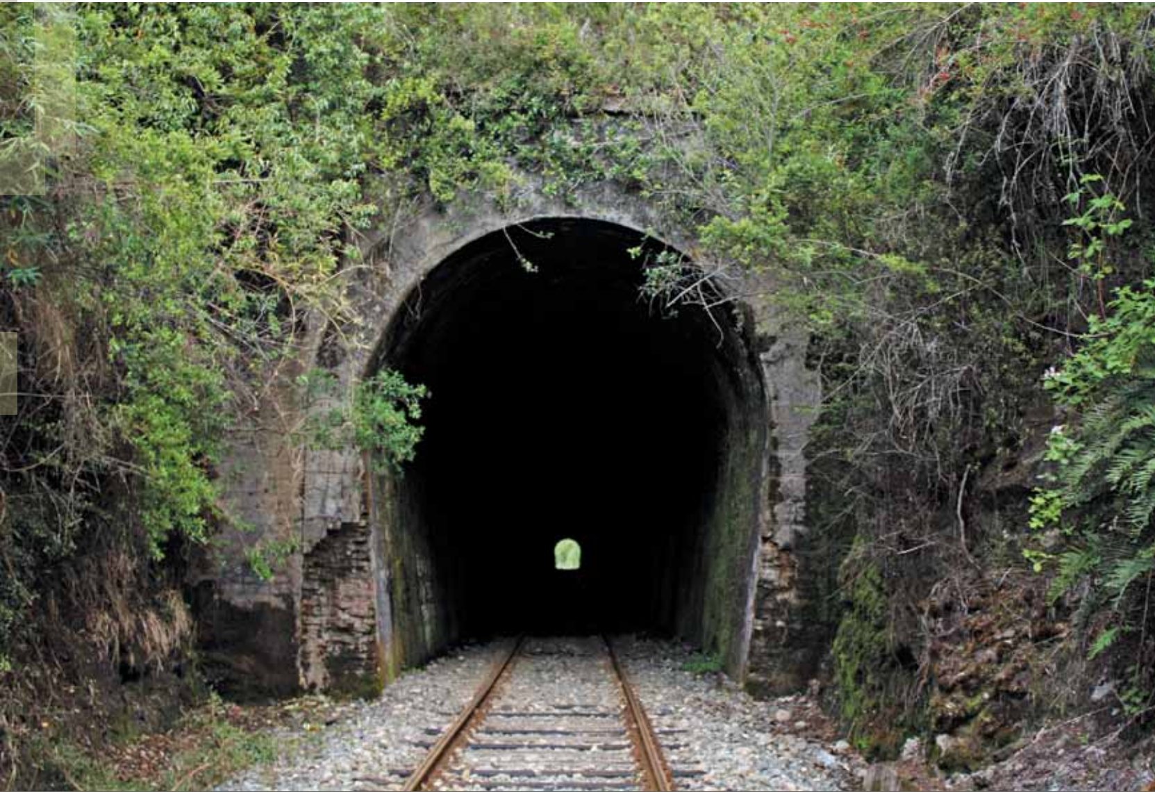
Fig. 6. Túnel ferroviario. Comuna Los Lagos.
